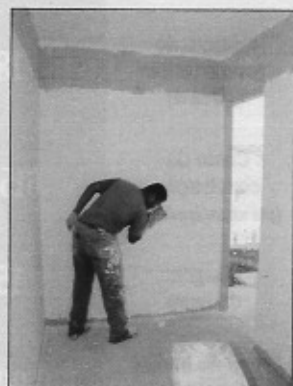
Dia 23 Pintura das paredes
